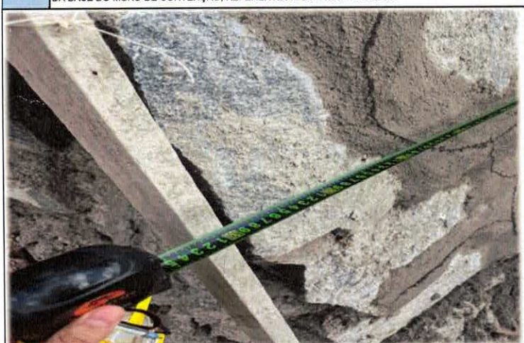
Foto n. 03 EXECUÇÃO DE MURO DE CONTENÇÃO EM PEDRA RACHÃO, COM ASSENTAMENTO EM ARGAMASSA, ENTRE AS ESTACAS E02 E E03.
