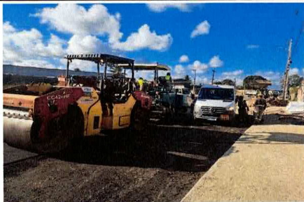
5.12 - TRANSPORTE COM CAMINHÃO BASCULANTE DE 18 M 3 (COMPLEMENTO)
