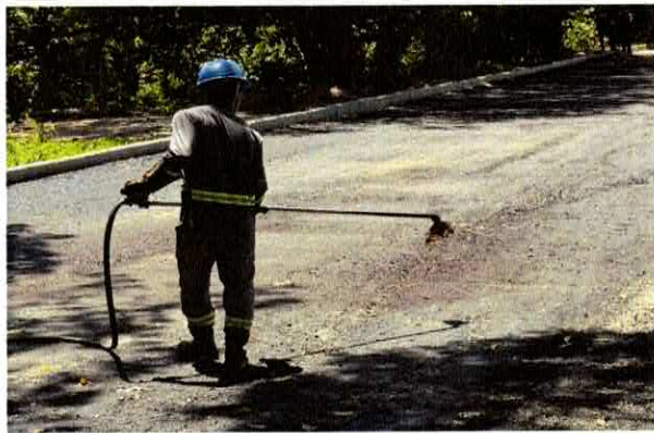
5.6 - EXECUÇÃO DE IMPRIMAÇÃO COM ASFALTO DIUIDO CM-30
