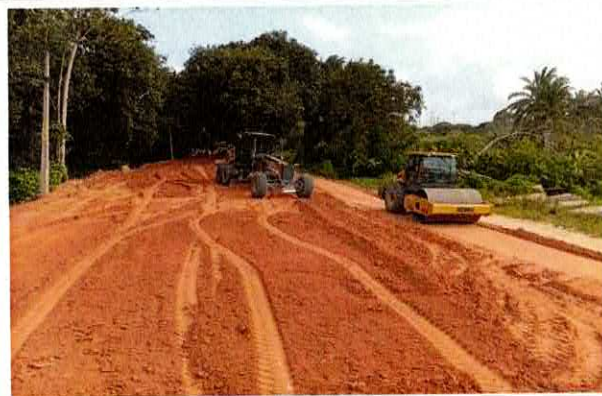
11.2.1 - TRANSPORTE COM CAMINHÃO BASCULANTE DE 10 M 3 (COMPLEMENTO)
