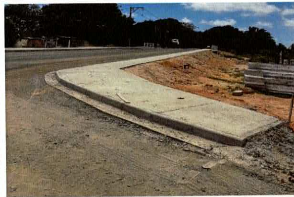
6.3 - EXECUÇÃO DE PASSEIO (CALÇADA) OU PISO DE CONCRETO
