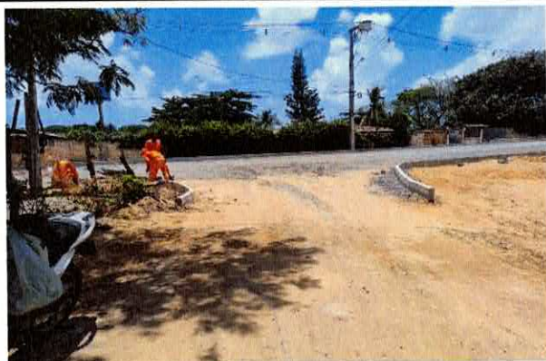
6.1 - REGULARIZAÇÃO MANUAL DE TERRENO, CORTE OU ATERRO ATÉ 20 CM DE ESPESSURA
