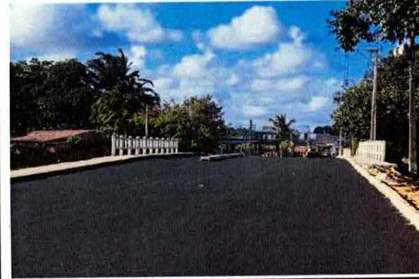
0.0.0 - PAVIMENTAÇÃO DO TRECHO DA ESTACA E-30 A E-49
