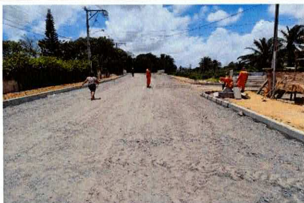
5.13 - ASSENTAMENTO DE GUIA (MEIO-FIO) EM TRECHO RETO
