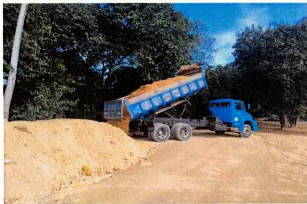
5.4 - CARGA, MANOBRA E DESCARGA DE SOLOS E MATERIAIS GRANULARES
