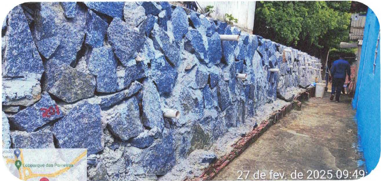
3.2.3. ALVENARIA EM PEDRA RACHÃO OU PEDRA DE MÃO, ASSENTADA COM ARGAMASSA TRAÇO 1:6 (CIMENTO E AREIA) - (OBRA 02).
