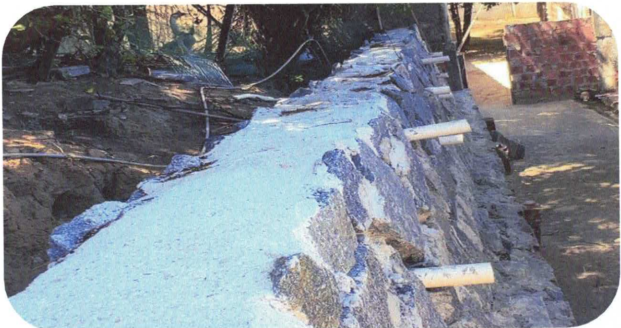
3.2.3. ALVENARIA EM PEDRA RACHÃO OU PEDRA DE MÃO, ASSENTADA COM ARGAMASSA TRAÇO 1:6 (CIMENTO E AREIA) - (OBRA 02).
