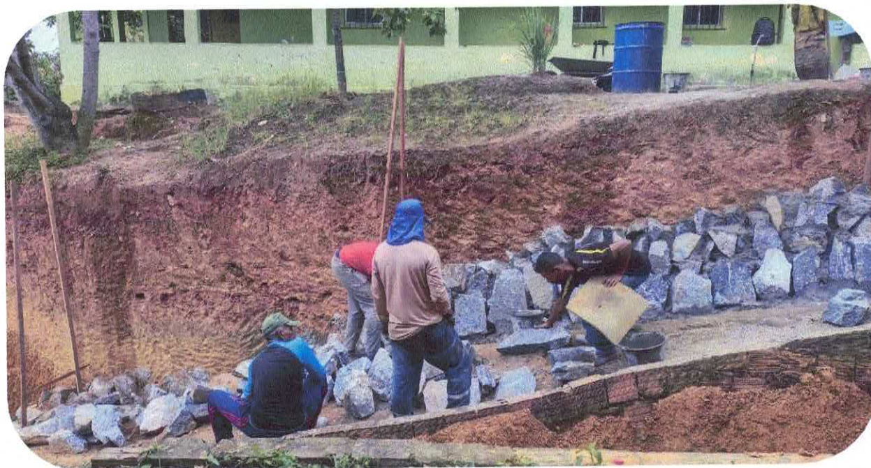
11.2.3. ALVENARIA EM PEDRA RACHAO OU PEDRA DE MAO, ASSENTADA COM ARGAMASSA TRACO 1:6 (CIMENTO E AREIA) - (OBRA 10).
