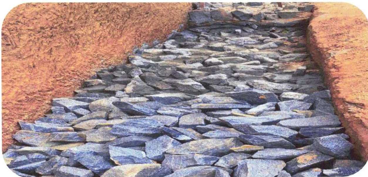
11.2.3. ALVENARIA EM PEDRA RACHAO OU PEDRA DE MAO, ASSENTADA COM ARGAMASSA TRACO 1:6 (CIMENTO E AREIA) - (OBRA 10).
