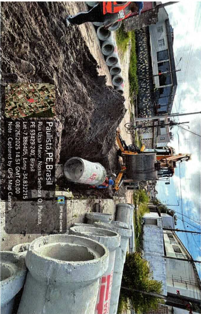
Foto n. 09 ASSENTAMENTO DE TUBO DE CONCRETO DE 600MM
