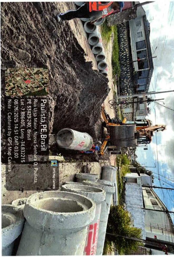
Foto n. 08 ASSENTAMENTO DE TUBO DE CONCRETO DE 600MM
