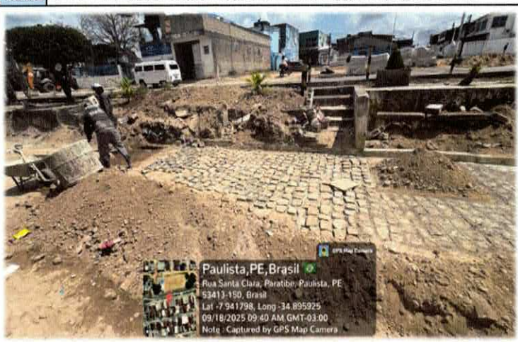
Foto n. 05 PAVIMENTO EM PARALELEPÍPEDO SOBRE COLCHÃO DE AREIA REJUNTADO COM ARGAMASSA DE CIMENTO NA RUA SANTA CLARA.
