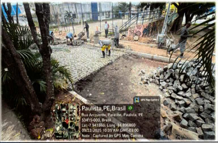
Foto n. 02 PAVIMENTO EM PARALELEPÍPEDO SOBRE COLCHÃO DE AREIA REJUNTADO COM ARGAMASSA DE CIMENTO.
