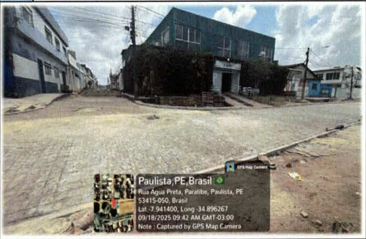
Foto n. 04 PAVIMENTO EM PARALELEPÍPEDO SOBRE COLCHÃO DE AREIA REJUNTADO COM ARGAMASSA DE CIMENTO.
