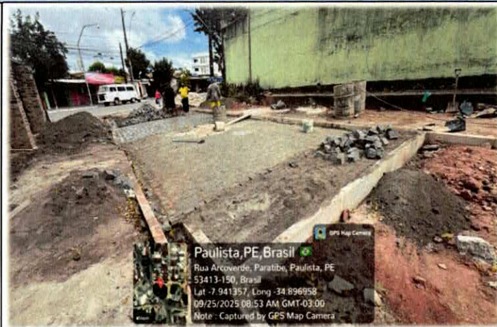
Foto n. 14 PAVIMENTO EM PARALELEPIPEDO SOBRE COLCHÃO DE AREIA REJUNTADO COM ARGAMASSA DE CIMENTO.
