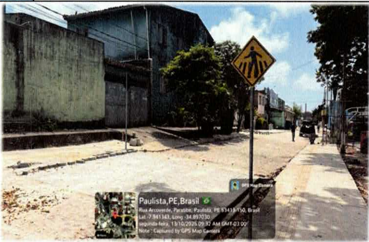
Foto n. 17 INSTALAÇÃO DE PLACA SINALIZADORA.
