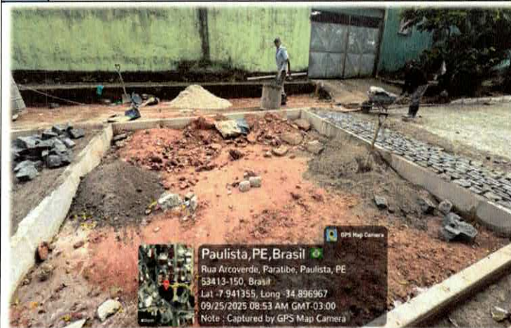
Foto n. 15 ASSENTAMENTO DE TRAVESSA ELEVADA PARA ROTA DE ACESSIBILIDADE.
