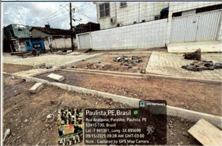
Foto n. 13 ASSENTAMENTO DE TRAVESSA ELEVADA PARA ROTA DE ACESSIBILIDADE.
