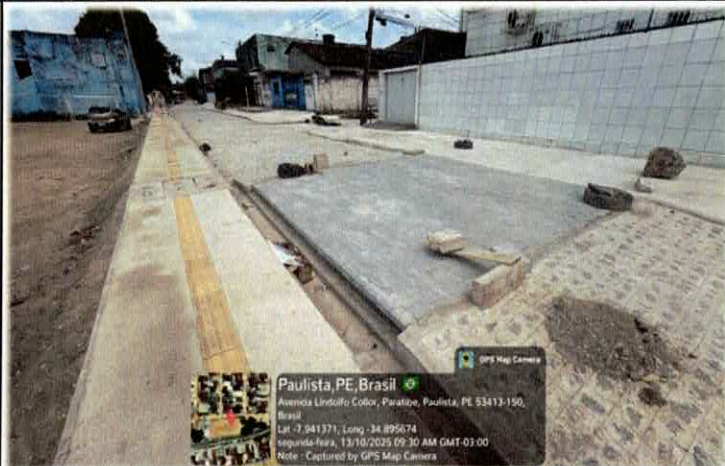
Foto n. 16 EXECUÇÃO DE PASSEIO EM PISO INTERTRAVADO COM BLOCO RETANGULAR.
