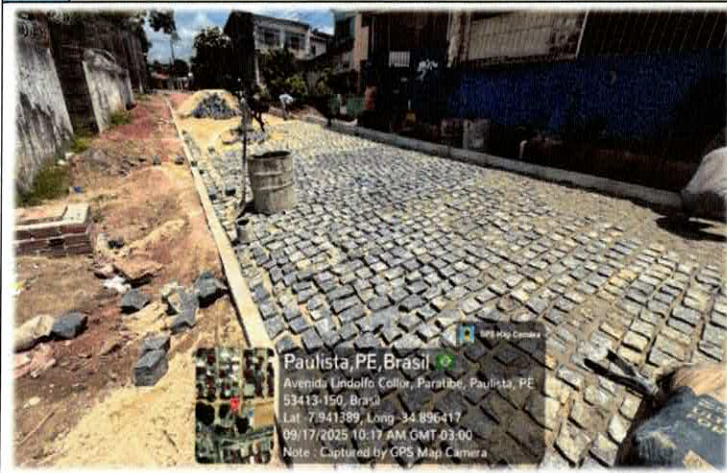
Foto n. 09 PAVIMENTO EM PARALELEPÍPEDO SOBRE COLCHÃO DE AREIA REJUNTADO COM ARGAMASSA DE CIMENTO.
