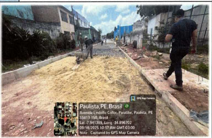
Foto n. 06 PAVIMENTO EM PARALELEPÍPEDO SOBRE COLCHÃO DE AREIA.
