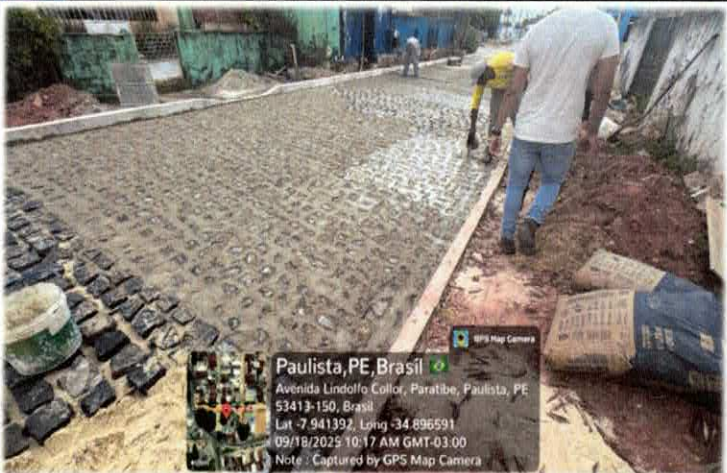
Foto n. 11 PAVIMENTO EM PARALELEPÍPEDO SOBRE COLCHÃO DE AREIA REJUNTADO COM ARGAMASSA DE CIMENTO.
