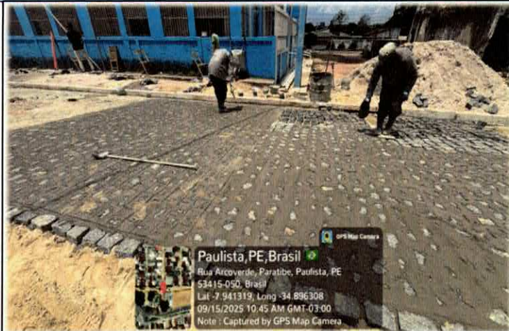
Foto n. 08 PAVIMENTO EM PARALELEPÍPEDO SOBRE COLCHÃO DE AREIA REJUNTADO COM ARGAMASSA DE CIMENTO.
