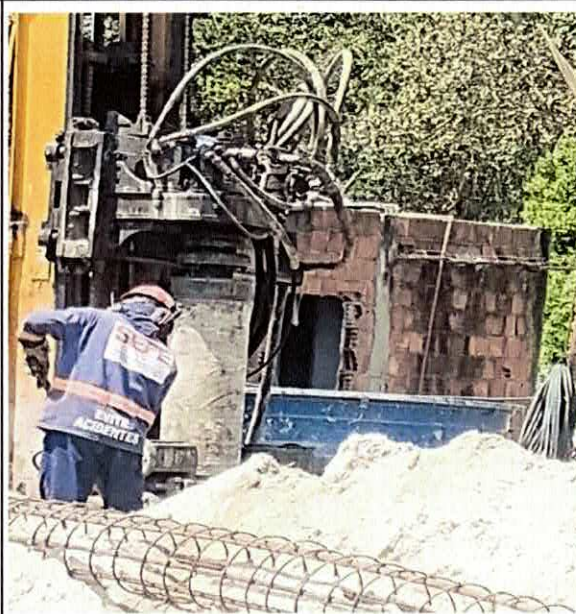
FOTO 06: 2.4.2.1.3. ESTACA RAÍZ, DIÂMETRO DE 40CM, SEM PRESENÇA DE ROCHA (EXCLUSIVE MOBILIZAÇÃO) 100931 SINAP 07/2020
