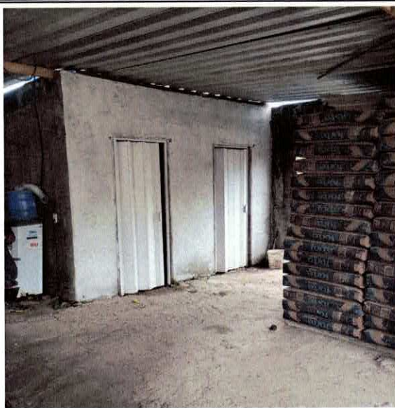
FOTO 23: EXECUÇÃO DE SANITÁRIO E VESTIÁRIO EM CANTEIRO DE OBRA EM ALVENARIA, NÃO INCLUSO MOBILIÁRIO. AF_02/2016
