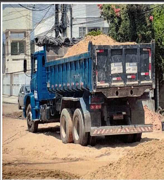
FOTO 02: 2.4.1.0.2. REMOÇÃO DE ENTULHO EM CAMINHÃO BASCULANTE DMT ATÉ 10KM, INCLUSIVE CARGA MECÂNICA E DESCARGA
