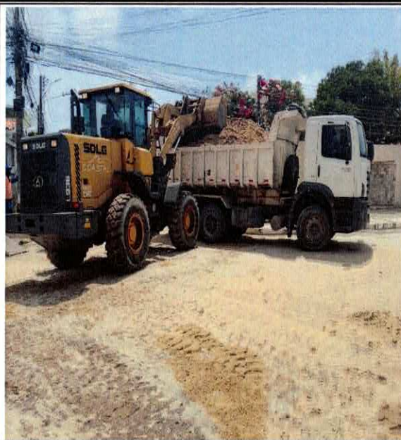
FOTO 01: 2.4.1.0.2. REMOÇÃO DE ENTULHO EM CAMINHÃO BASCULANTE DMT ATÉ 10KM, INCLUSIVE CARGA MECÂNICA E DESCARGA
