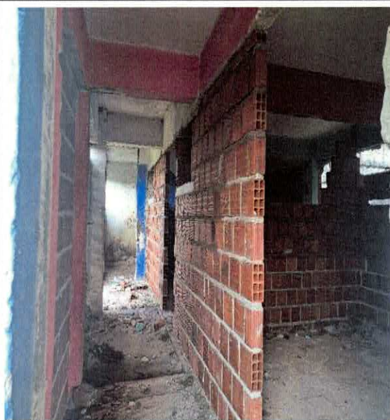
FOTO 07: 3.4.0.0.1. ALVENARIA EM TIJOLO CERAMICO FURADO, 1/2 VEZ, ASSENTADO EM ARGAMASSA TRACO 1:4 (CIMENTO E AREIA MEDIA NAO PENEIRADA), PREPARO MANUAL, JUNTA 1 CM
