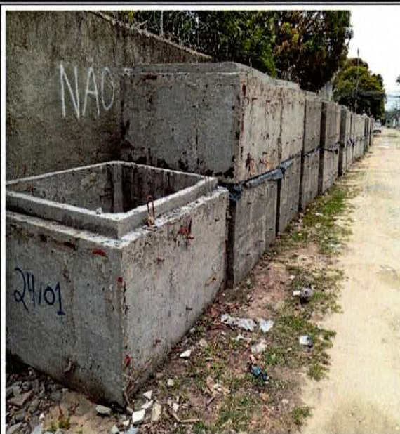
FOTO 14: 5.2.0.0.5. FORNECIMENTO DE ADUELAS PREMOLDADAS EM CONCRETO ARMADO FCK 25 MPA SEÇÃO 2,2 X 1,5 INCLUSIVE FORMA, ESCORAMENTO E ARMAÇÃO.
