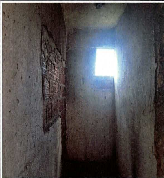
FOTO 10: 3.4.0.0.1. ALVENARIA EM TIJOLO CERAMICO FURADO, 1/2 VEZ, ASSENTADO EM ARGAMASSA TRACO 1:4 (CIMENTO E AREIA MEDIA NAO PENEIRADA), PREPARO MANUAL, JUNTA 1 CM
