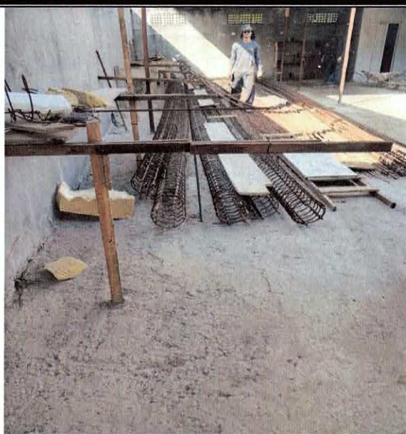
FOTO 03: 2.4.2.1.3. ESTACA RAÍZ, DIÂMETRO DE 40CM, SEM PRESENÇA DE ROCHA (EXCLUSIVE MOBILIZAÇÃO) 100931 SINAP 07/2020
