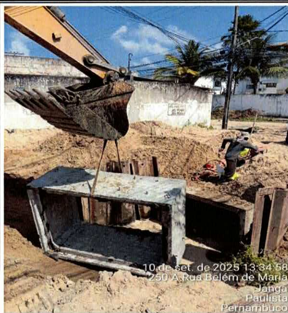
FOTO 17: 5.2.0.0.8.: ASSENTAMENTO DE ADUELAS PREMOLDADAS EM CONCRETO ARMADO SEÇÃO 2,2 X 1,5
