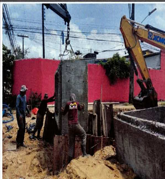
FOTO 15: ASSENTAMENTO DE ADUELAS PREMOLDADAS EM CONCRETO ARMADO SEÇÃO 2,2 X 1,5
