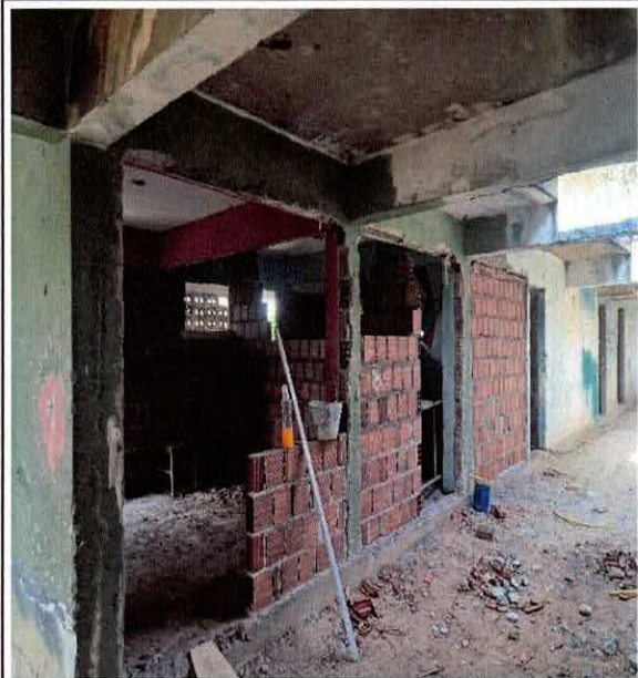
FOTO 08: 3.4.0.0.1. ALVENARIA EM TIJOLO CERAMICO FURADO, 1/2 VEZ, ASSENTADO EM ARGAMASSA TRACO 1:4 (CIMENTO E AREIA MEDIA NAO PENEIRADA), PREPARO MANUAL, JUNTA 1 CM
