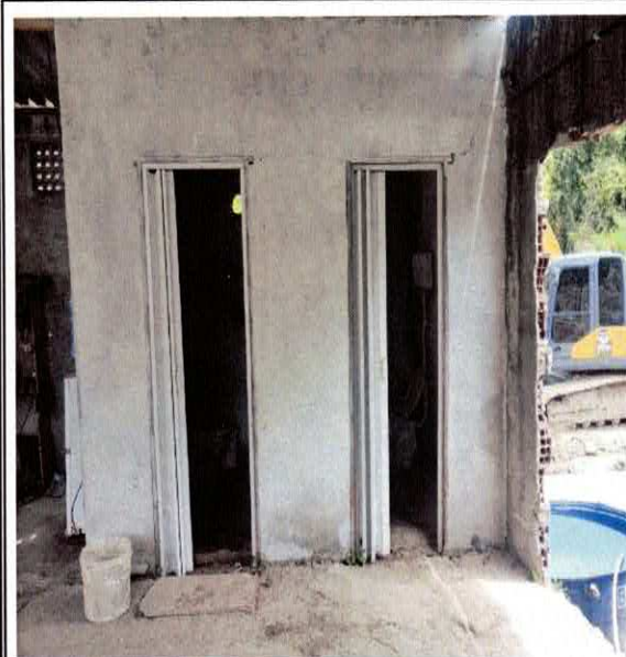
FOTO 24: EXECUÇÃO DE SANITÁRIO E VESTIÁRIO EM CANTEIRO DE OBRA EM ALVENARIA, NÃO INCLUSO MOBILIÁRIO. AF_02/2016
