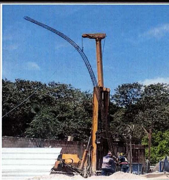
FOTO 04: 2.4.2.1.3. ESTACA RAÍZ, DIÂMETRO DE 40CM, SEM PRESENÇA DE ROCHA (EXCLUSIVE MOBILIZAÇÃO) 100931 SINAP 07/2020
