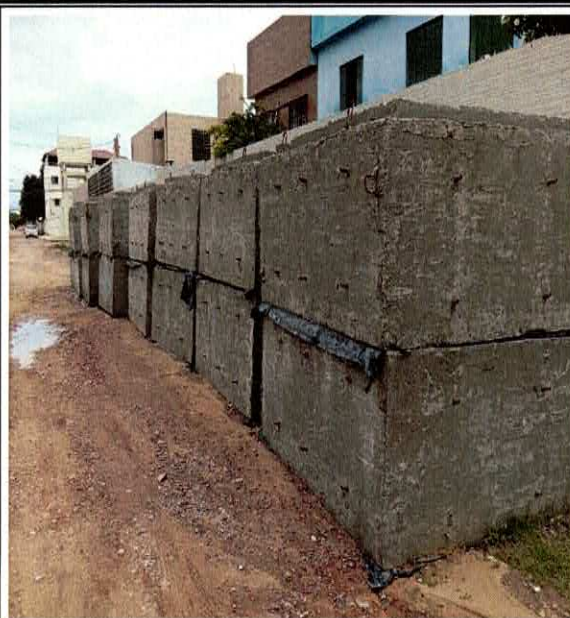
FOTO 13: 5.2.0.0.5. FORNECIMENTO DE ADUELAS PREMOLDADAS EM CONCRETO ARMADO FCK 25 MPA SEÇÃO 2,2 X 1,5 INCLUSIVE FORMA, ESCORAMENTO E ARMAÇÃO.
