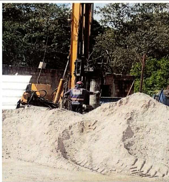
FOTO 05: 2.4.2.1.3. ESTACA RAÍZ, DIÂMETRO DE 40CM, SEM PRESENÇA DE ROCHA (EXCLUSIVE MOBILIZAÇÃO) 100931 SINAP 07/2020
