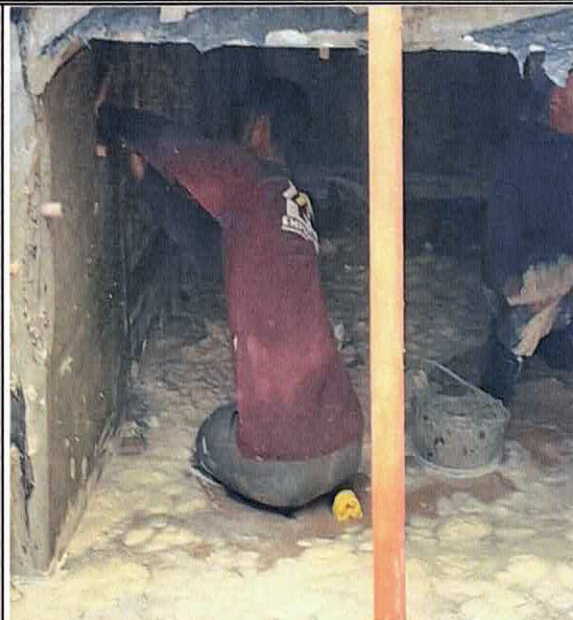
FOTO 18: 5.2.0.0.8. ASSENTAMENTO DE ADUELAS PREMOLDADAS EM CONCRETO ARMADO SEÇÃO 2,2 X 1,5
