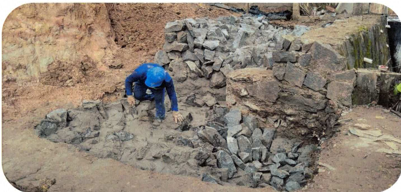
1.2.11 ALVENARIA DE PEDRA RACHÃO, ESTACA E0+7,40
