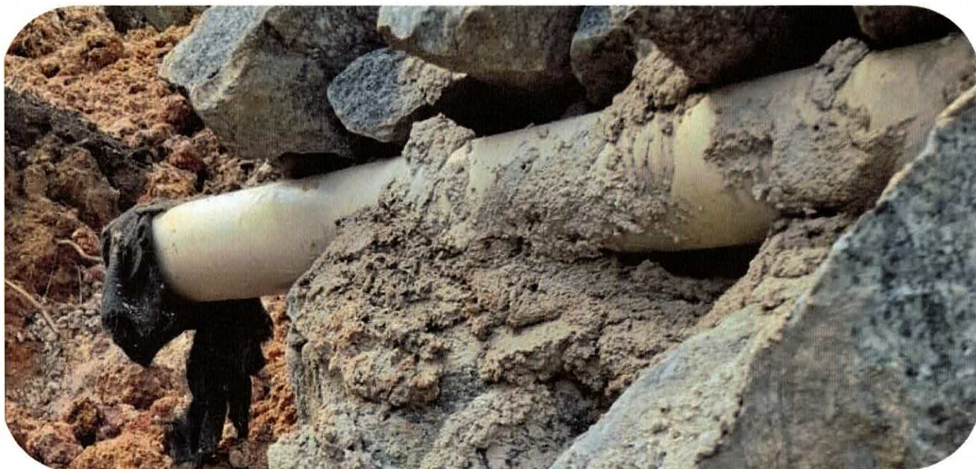
1.2.8 FORNECIMENTO/INSTALAÇÃO DE MANTA BIDIM
