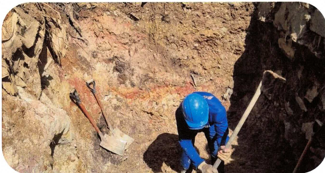
1.2.3 ESCAVAÇÃO MANUAL ESTACA 0+7,40
