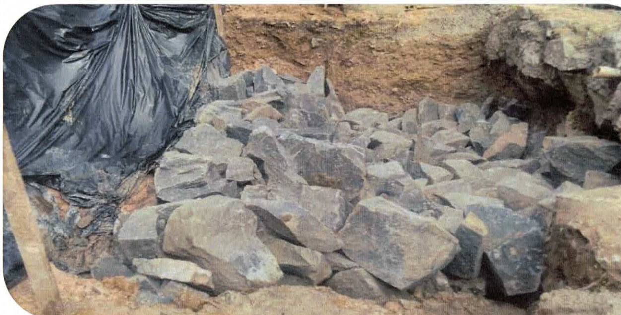
1.2.11 ALVENARIA DE PEDRA RACHÃO, ESTACA E0+7,40
