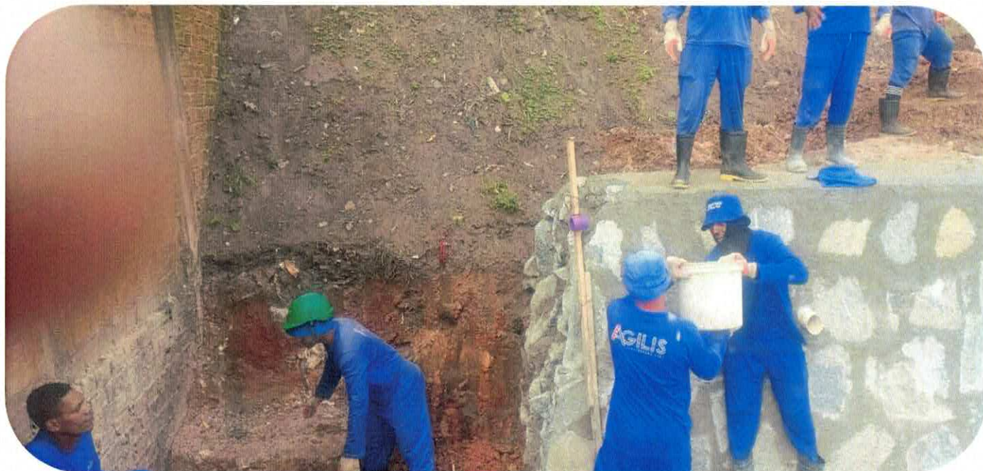
1.2.3 ESCAVAÇÃO MANUAL ESTACA E2+3,05
