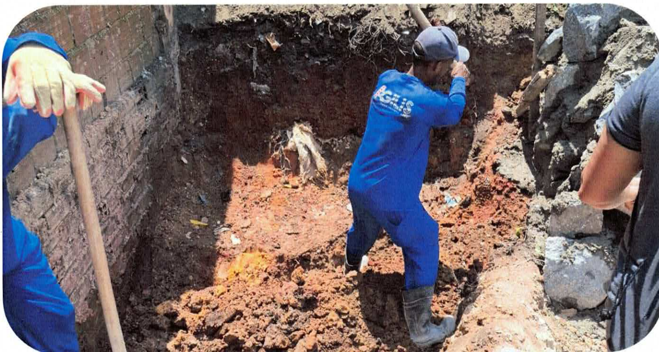
1.2.3 ESCAVAÇÃO MANUAL ESTACA E1+17,55
