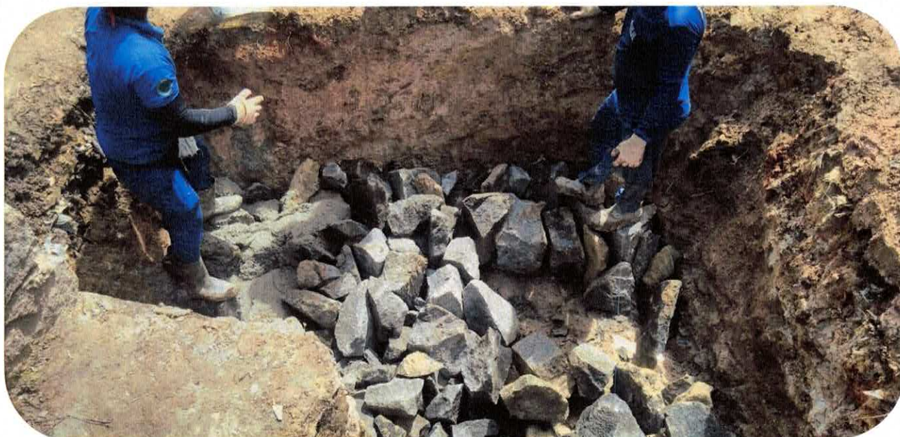
1.2.11 ALVENARIA DE PEDRA RACHÃO, ESTACA E0+7,40
