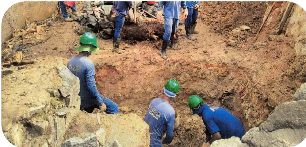
1.2.3 ESCAVAÇÃO MANUAL ESTACA E0+7,40
