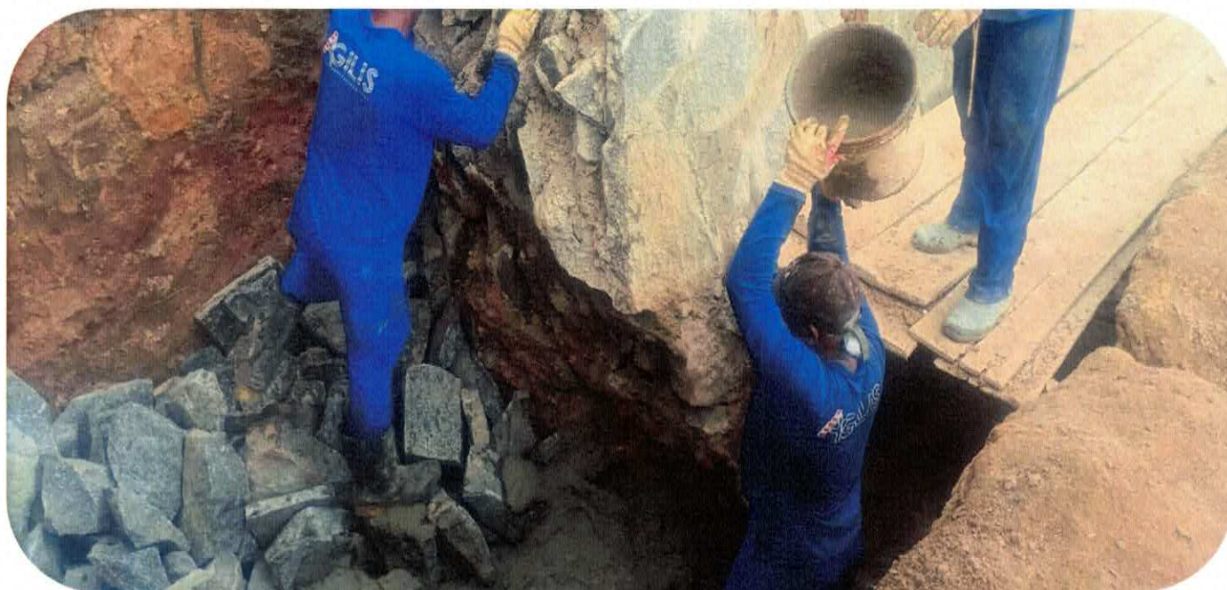
1.2.9 CONCRETO NÃO ESTRUTURAL
