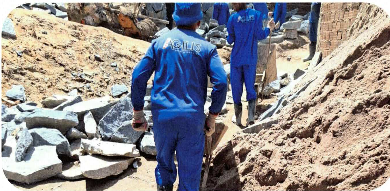
1.2.4 - TRANSPORTE HORIZONTAL DE MATERIAIS DIVERSOS
