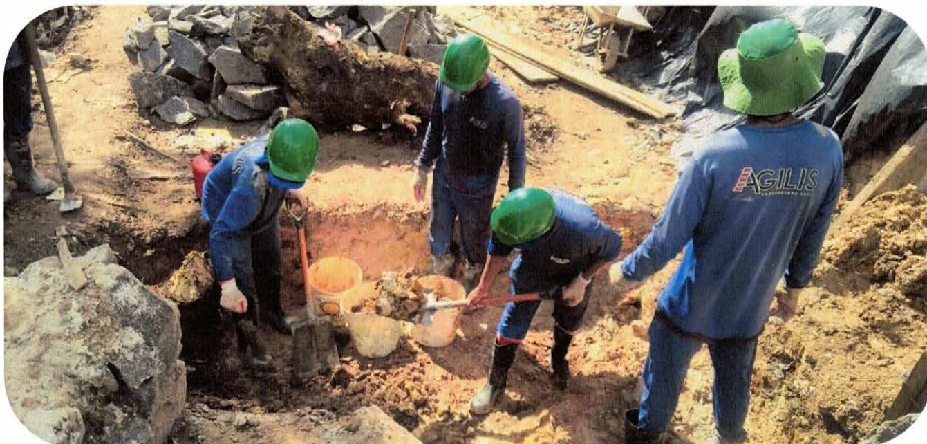
1.2.3 ESCAVAÇÃO MANUAL ESTACA E0+7,40
