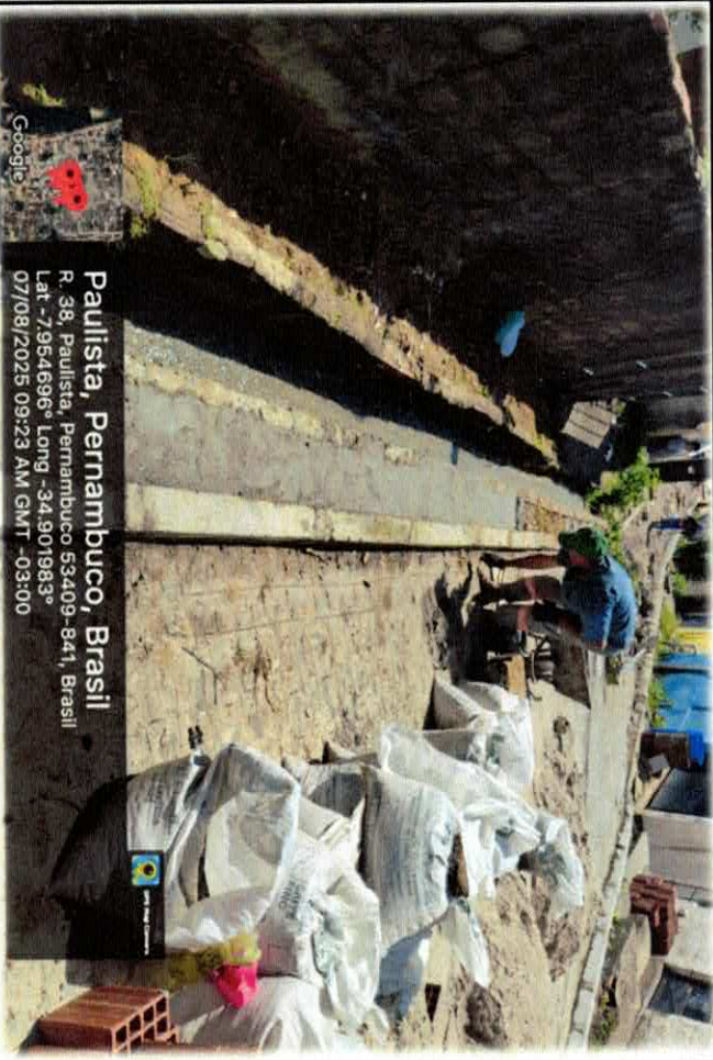
Foto n. 12 REGULARIZAÇÃO E COMPACTAÇÃO
