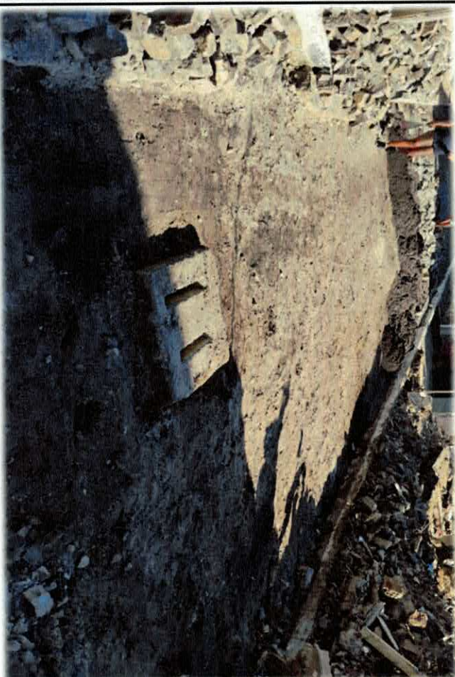
Foto n. 16 REGULARIZAÇÃO DO SUBLEITO (RUA 30)
