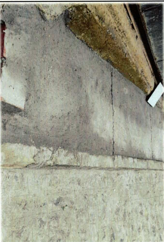
Foto n. 14 EXECUÇÃO DE PASSEIO (CALÇADA) OU PISO DE CONCRETO
