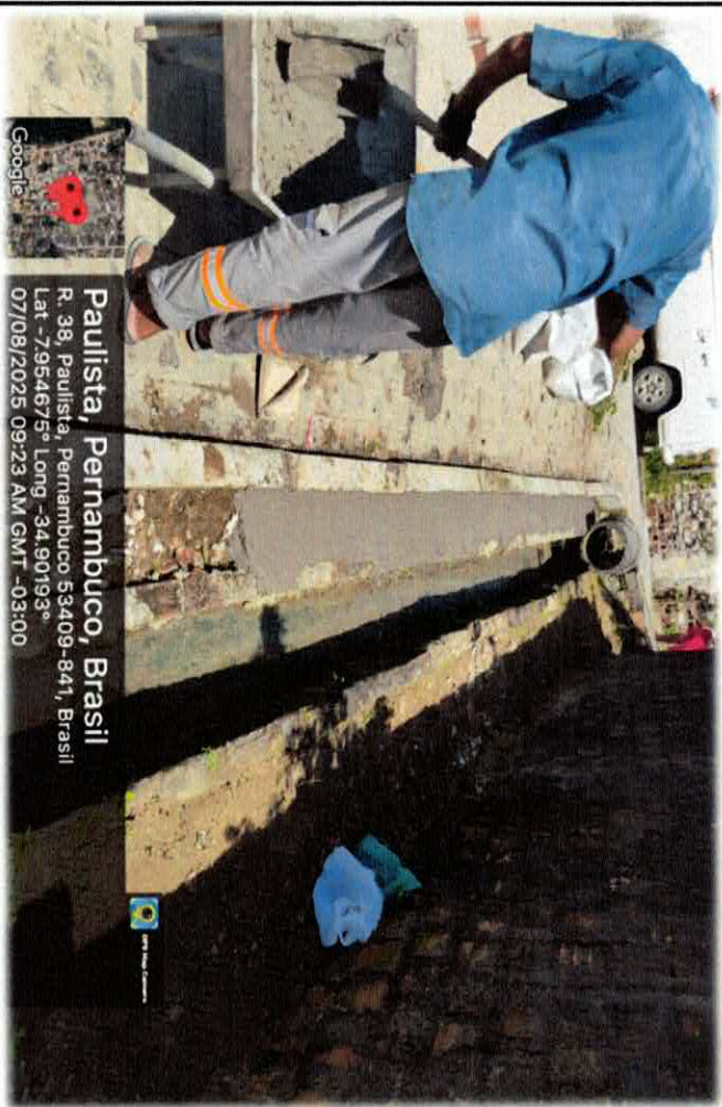
Foto n. 11 REGULARIZAÇÃO E COMPACTAÇÃO
