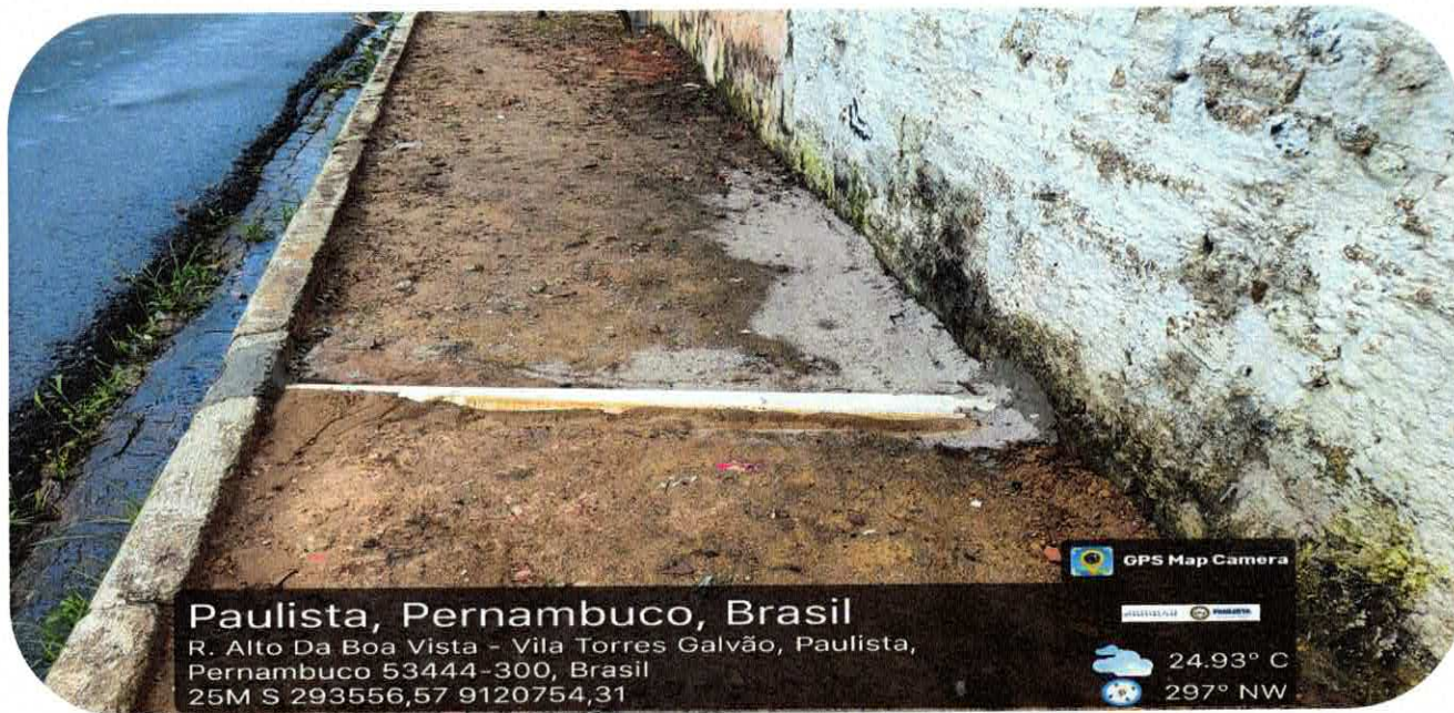
1.3.3. FORNECIMENTO E ASSENTAMENTO DE TUBO PVC COM JUNTA ELÁSTICA, DN 150 MM - (OU RPVC, OU PRFV) - PARA ESGOTO, INCLUSIVE ESCAVAÇÃO E REATERRO.
