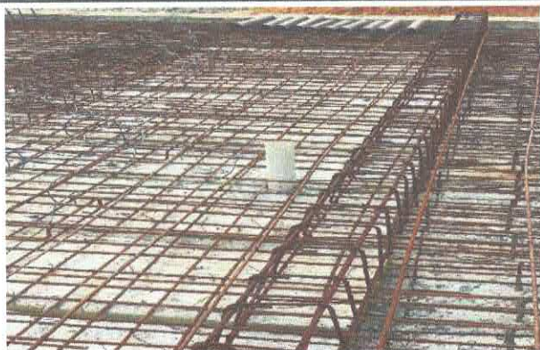
9.3.3 - Fornecimento e Instalação de Dreno de PVC para OAE
