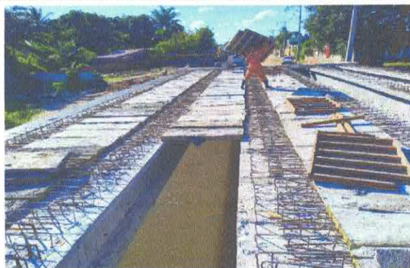
9.2.6 - Lançamento de pré-laje sobre as vigas pré-moldadas
