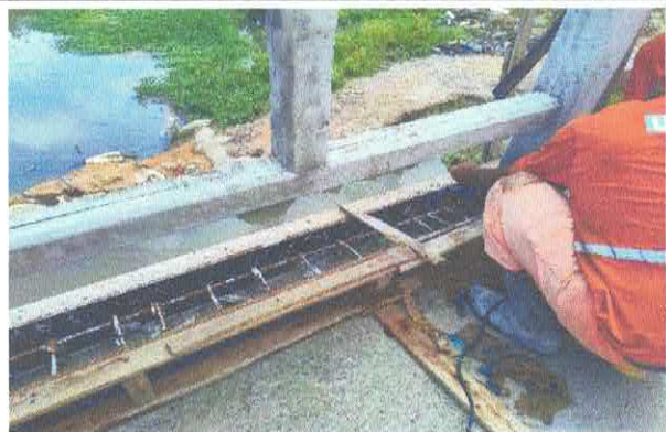
9.2.5 - Confeção, instalação e retirada de fôrmas de compensado resinado das bases dos guarda corpos
