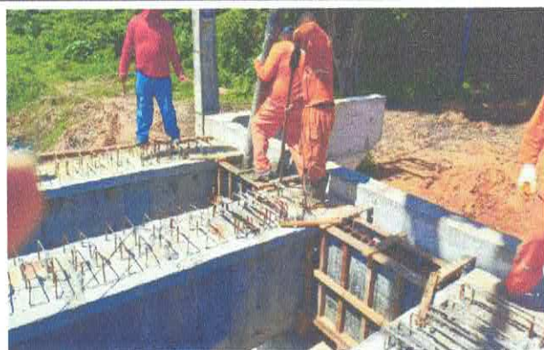
9.1.7 - Bombeamento de concreto das transversinas
