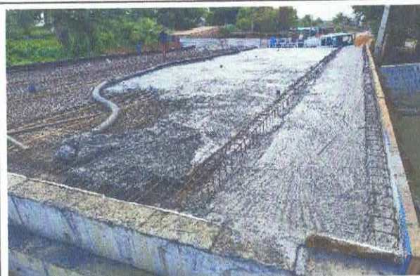
9.2.2 - Lançamento mecânico de concreto da laje da ponte
