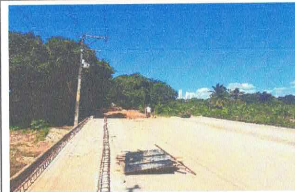
0.0.0 - Concretagem da ponte
