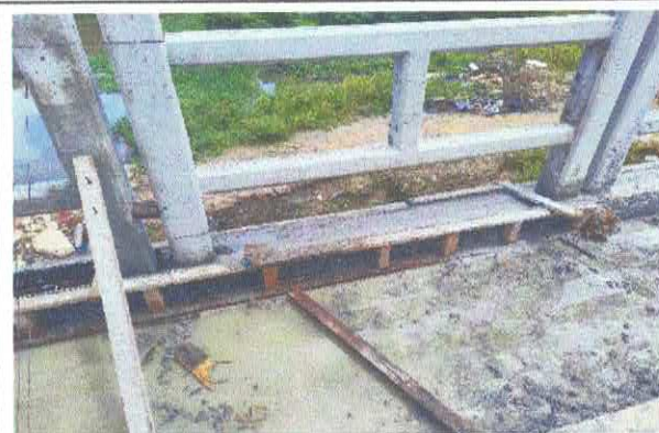
9.3.2 - Lançamento mecânico de concreto das bases dos guarda corpos e meios-fios
