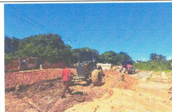
9.5.2 - Regularização de bota-fora com espalhamento e compactação
