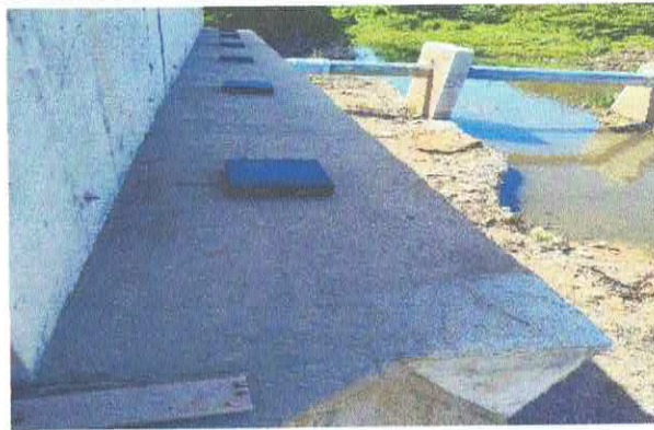
9.1.14 - Fornecimento e instalação de aparelho de apoio de neoprene
