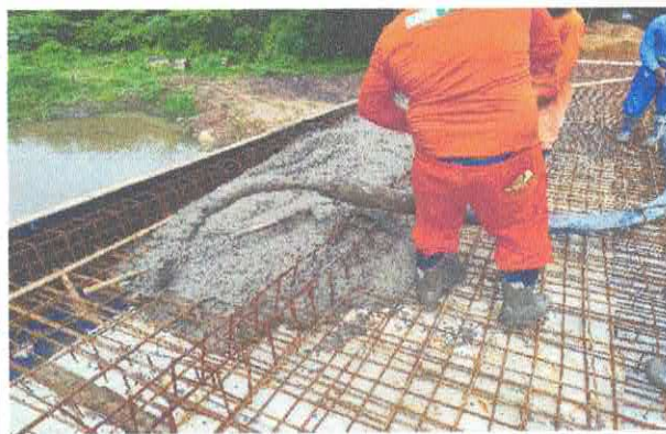
9.1.8 - Lançamento mecânico de concreto das transversinas
