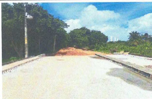
9.3.5 - Fornecimento e Instalação de Junta de dilatação
