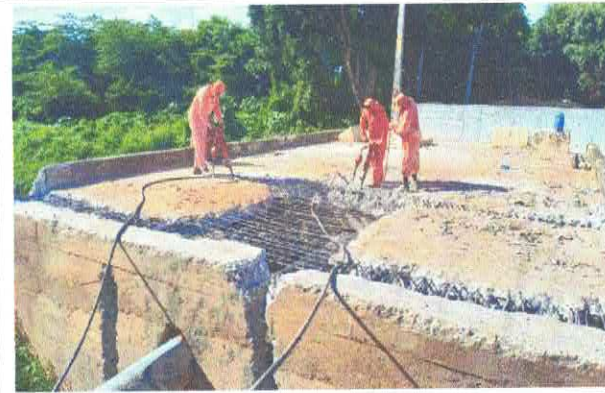
9.5.1 - Demolição mecânica de concreto armado com escavadeira hidráulica com martelo hidráulico
