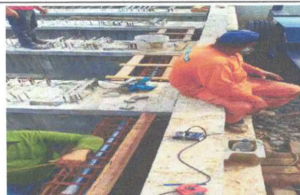
9.2.8 - Fornecimento e Instalação de Ancoragem ativa das transversinas
