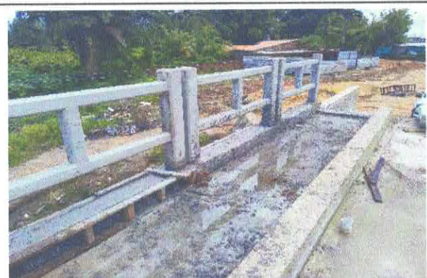
9.3.1 - Bombeamento de concreto das bases dos guarda corpos e meios-fios
