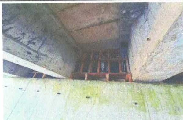
9.1.9 - Confeção, instalação e retirada de fôrmas de compensado resinado das transversinas e lajes da ponte
