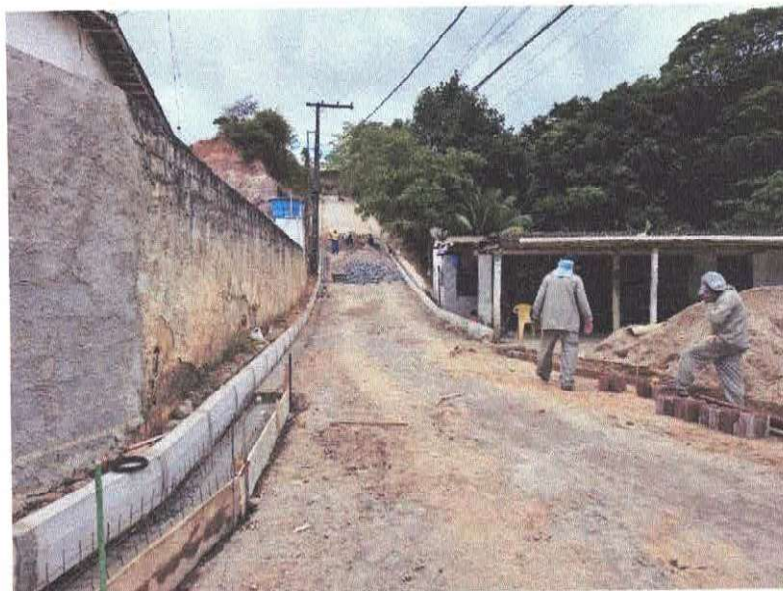
Foto 02: ASSENTAMENTO DE GUIA (MEIO-FIO) (Novembro/2024)
