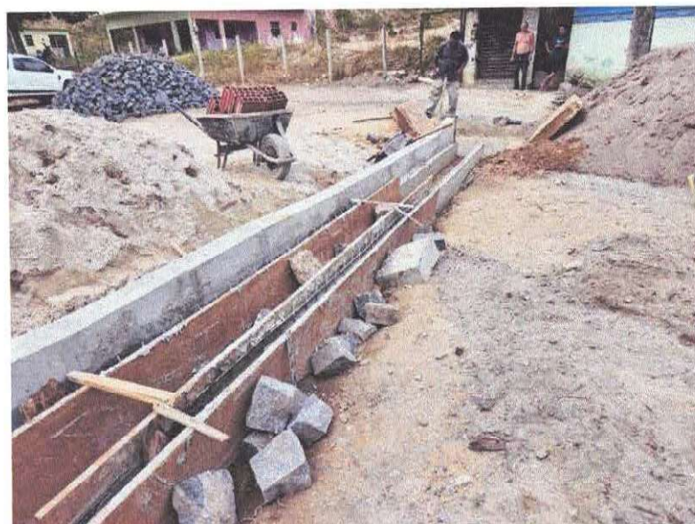
Foto 6: EXECUÇÃO DE CANALETA DE DRENAGEM EM CONCRETO (Novembro/2024)
