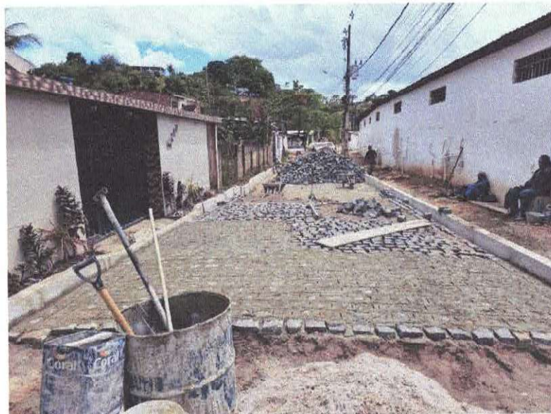
Foto 10: EXECUÇÃO DE PAVIMENTO (Novembro /2024)
