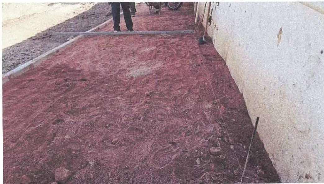
Foto 9: EXECUÇÃO DE ATERRO (Novembro/2024)
