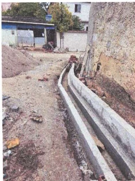
Foto 7: EXECUÇÃO DE CANALETA DE DRENAGEM EM CONCRETO (Novembro/2024)
