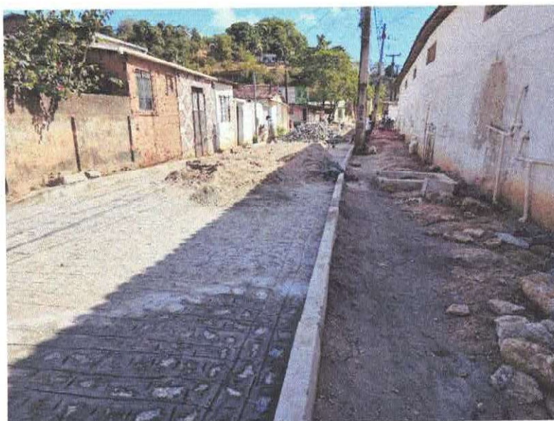
Foto 04: EXECUÇÃO DE PAVIMENTO (Novembro/2024)
