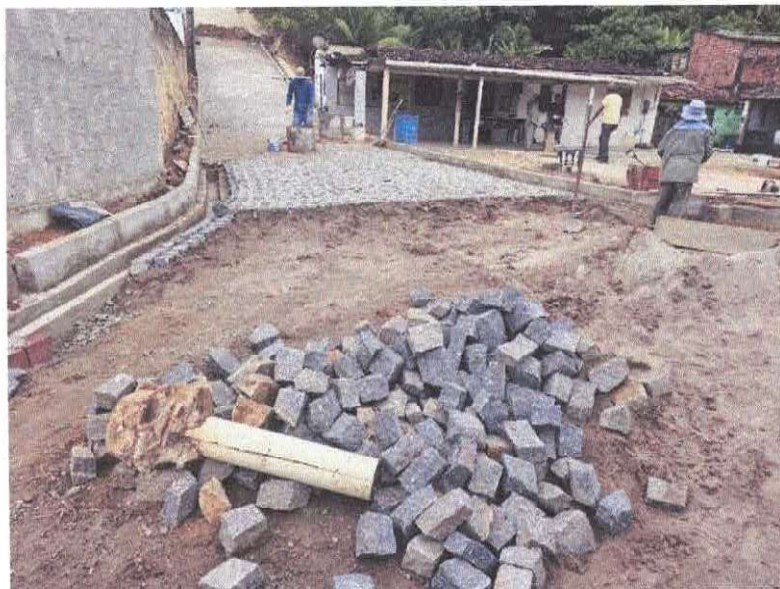
Foto 03: EXECUÇÃO DE PAVIMENTO (Novembro/2024)
