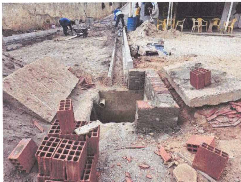
Foto 5: EXECUÇÃO DE CANALETA DE DRENAGEM EM CONCRETO (Novembro/2024)
