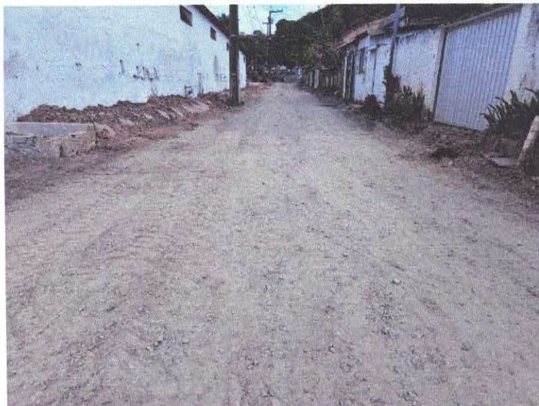
Foto 01: EXECUÇÃO E COMPACTAÇÃO DE BASE (Novembro/2024)
