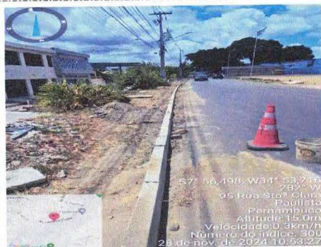
SERVIÇO DE INSTALAÇÃO DE MEIO FIO – RUA SANTA CLARA, PAULISTA/PE
