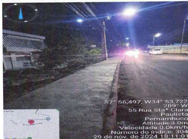
EXECUÇÃO DE CALÇADA – RUA SANTA CLARA, PAULISTA/PE
