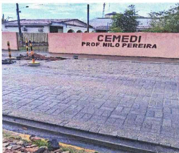
EXECUÇÃO DE TRAVESSIA – DR. JOSÉ MARIANO
