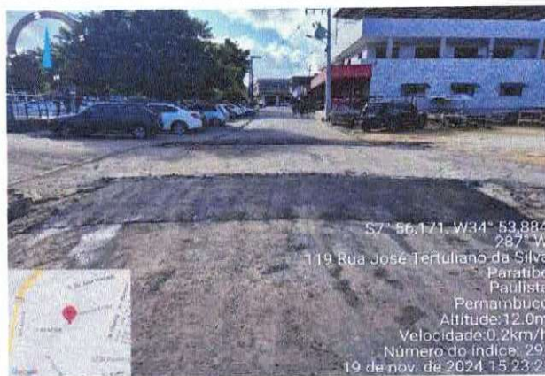
SERVIÇO DE ACABAMENTO COM ASFALTO NA TRAVESSIA – RUA JOSE TERTULIANO DA SILVA, PARATIBE – PAULISTA /PE
