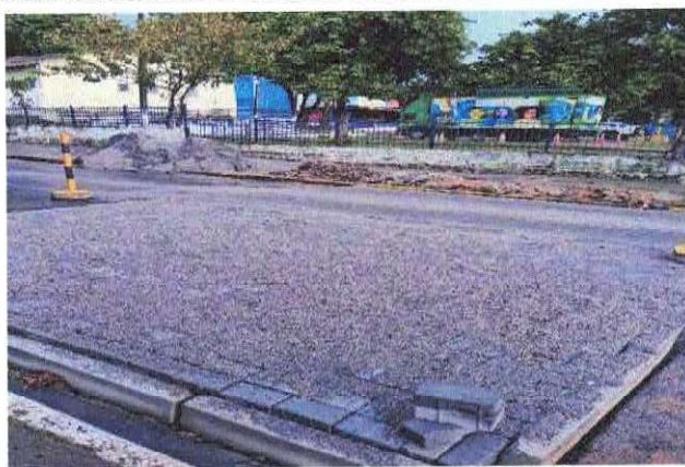
EXECUÇÃO DE TRAVESSIA – RUA JOSE TERTULIANO DA SILVA, PARATIBE – PAULISTA /PE
