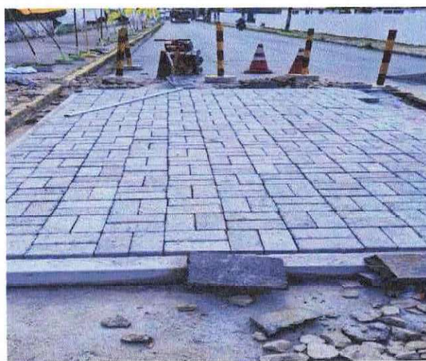
EXECUÇÃO DE TRAVESSIA - DR. JOSÉ MARIANO
