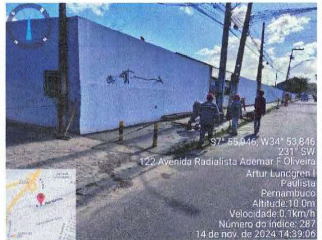
EXECUÇÃO DE CALÇADA – AVENIDA R. ADEMAR F. OLIVEIRA, ARTUR LUNDGREN I – PAULISTA/PE
