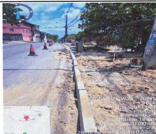
SERVIÇO DE INSTALAÇÃO DE MEIO FIO – RUA SANTA CLARA, PAULISTA/PE
