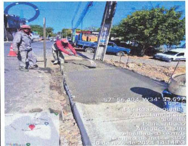
EXECUÇÃO DE CALÇADA – RUA ALAGOINHA, ARTUR LUNDGREN I – PAULISTA/PE
