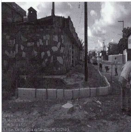
Figura 25 – Assentamento dos Meio-Fios no trecho curvo situado da estaca E 11 do lado Direito do sentido crescente do estaqueamento da Via.
