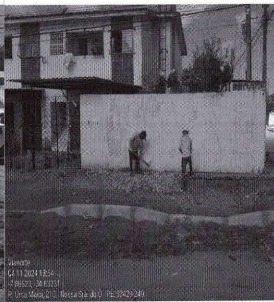
Figura 38 – Demolição de calçada para melhor execução e urbanismo do passeio pós concretagem das calçadas nas proximidades da E 11.
