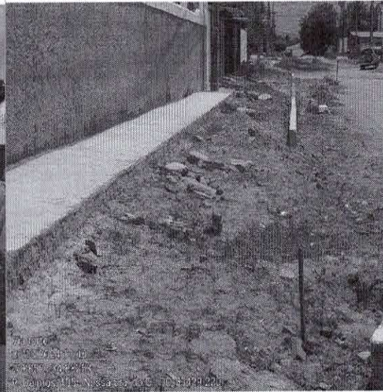
Figura 26 – Assentamento dos Meio-Fios no trecho situado da estaca E 11 até a E 8 + 10 do lado Esquerdo do sentido crescente do estaqueamento da Via.
