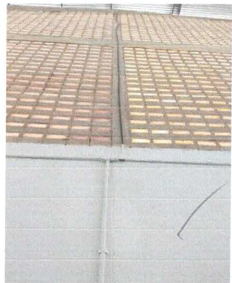
Foto 46: 1.3.0.29. Eletroduto rígido soldável, pvc, dn 25 mm (3/4") (07/10/22 a 06/11/22)
