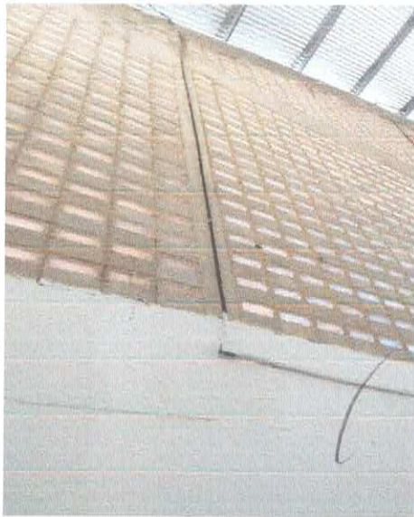
Foto 45: 1.3.0.28. Eletroduto rígido soldável, pvc, dn 20 mm (1/2") (07/10/22 a 06/11/22)
