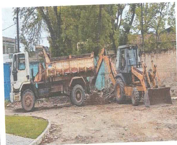
Foto 08: 1.4.1.11. Remoção de material em caminhão basculante (24/10/22)
