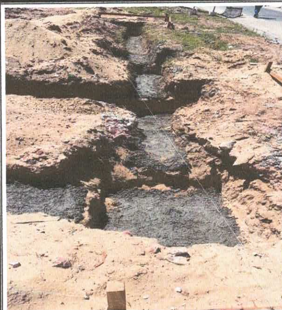
Foto 07: 6.2.0.1. Concreto magro para lastro, preparo com betoneira. (01/01/24 a 10/02/24)
