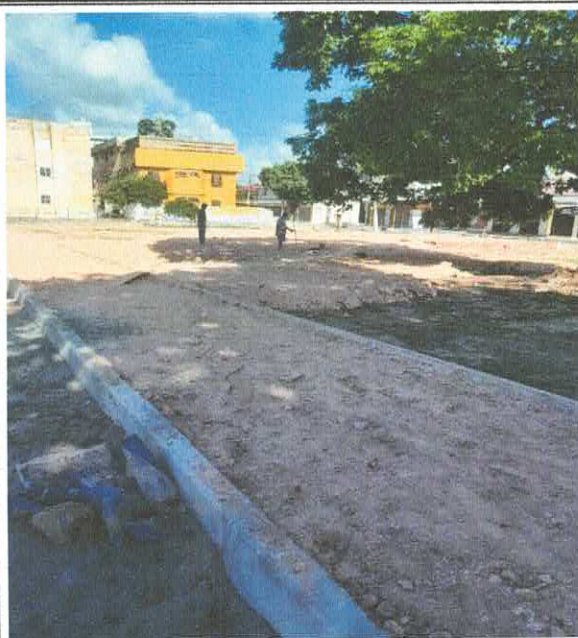
Foto 13: 7.1.0.1. Regularização manual do terreno, corte ou aterro. (01/01/24 a 10/02/24)
