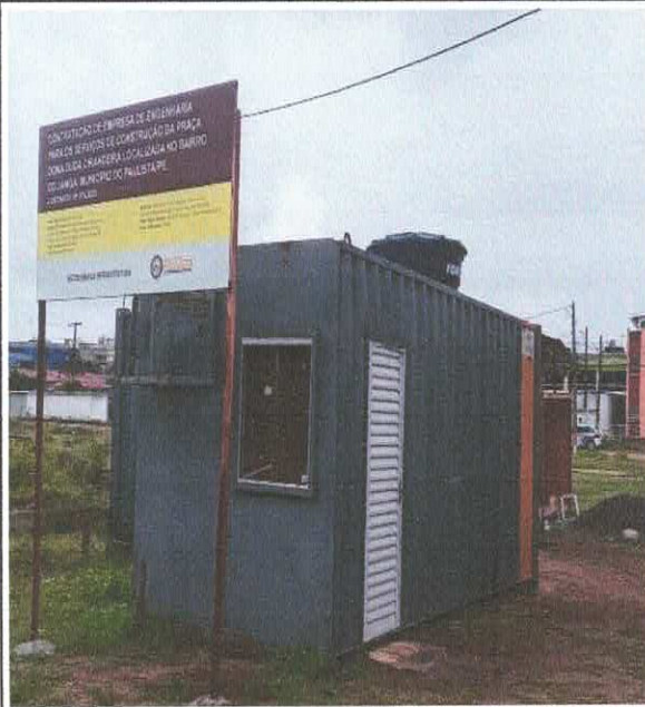
Foto 02: 2.1.0.4. Locação de container simples para almoxarifado. (01/01/24 a 10/02/24)
