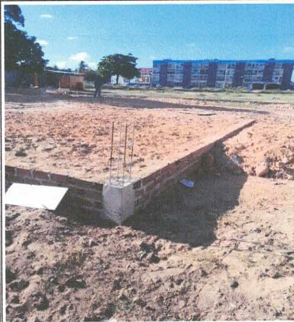
Foto 06: 6.1.0.2. Reaterro manual apiloado com soquete. (01/01/24 a 10/02/24)
