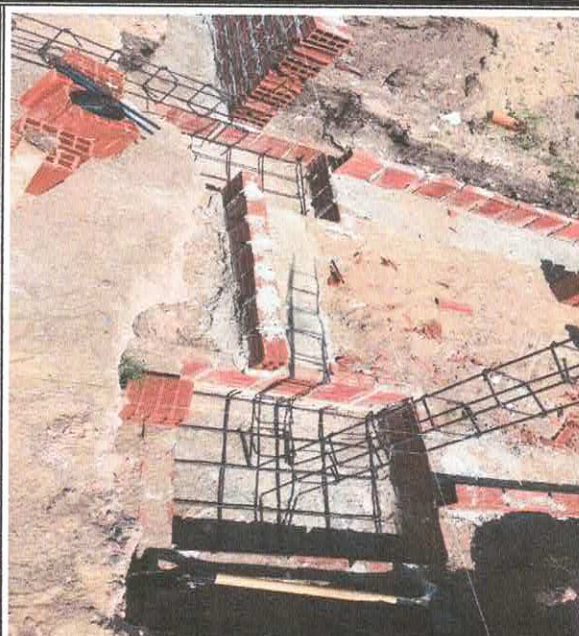
Foto 10: 6.2.0.4. Armação de bloco, viga, etc... com aço ca-50 de 8,0 mm. (01/01/24 a 10/02/24)
