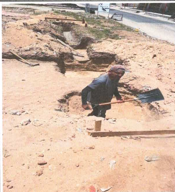
Foto 05: 6.1.0.1. Escavação manual de vala menor ou igual a 1,30 m. (01/01/24 a 10/02/24)
