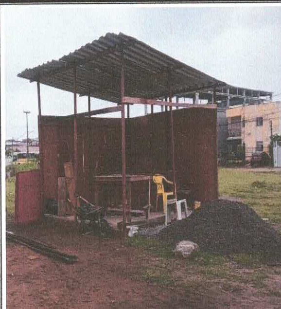
Foto 03: 2.1.0.5. Execução de refeitório em canteiro de obra. (01/01/24 a 10/02/24)
