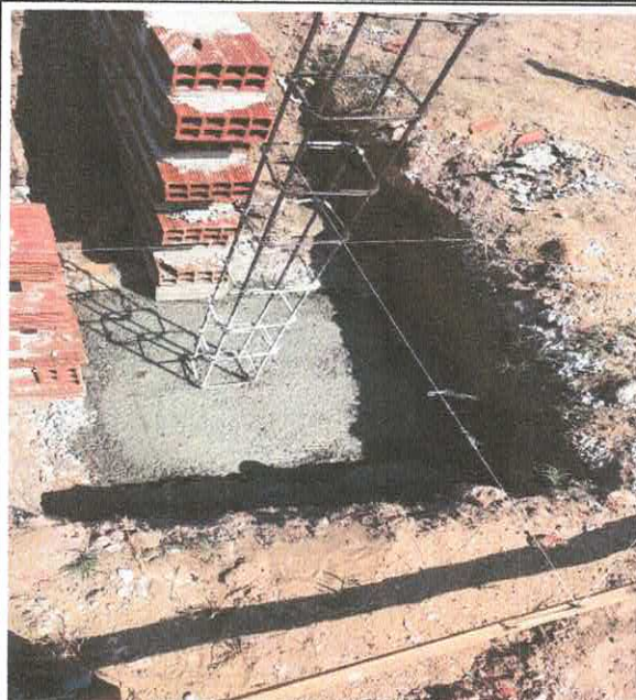
Foto 09: 6.2.0.3. Armação de bloco, viga, etc... com aço ca-50 de 6,3 mm. (01/01/24 a 10/02/24)
