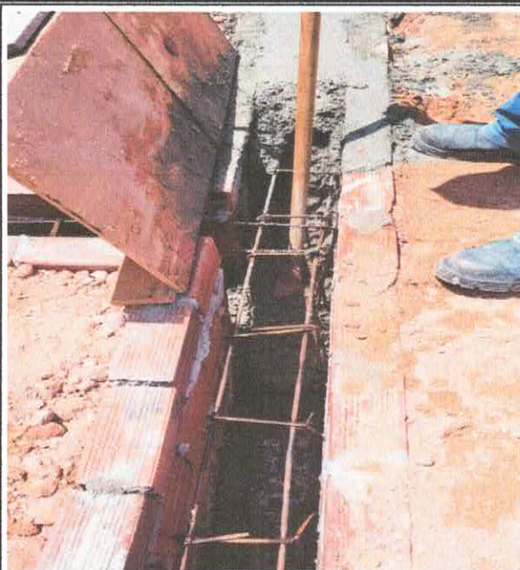
Foto 12: 6.2.0.6. Lançamento de concreto com uso de baldes. (01/01/24 a 10/02/24)
