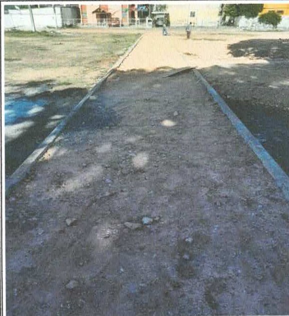
Foto 14: 7.1.0.2. Execução e compactação de aterro com solo argiloso. (01/01/24 a 10/02/24)
