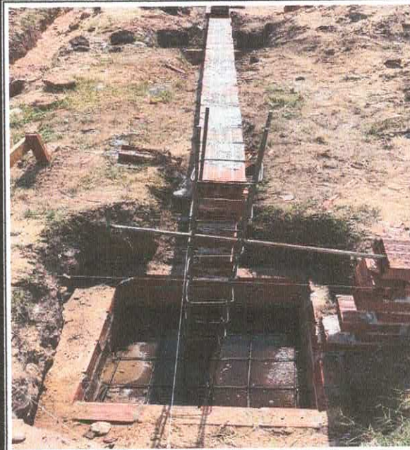
Foto 08: 6.2.0.2. Montagem e desmontagem de fôrma para sapata (01/01/24 a 10/02/24)
