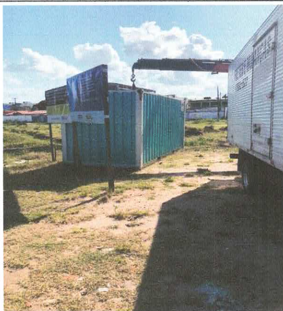
Foto 01: 2.1.0.2. Locação de container com sanitário. (01/01/24 a 10/02/24)
