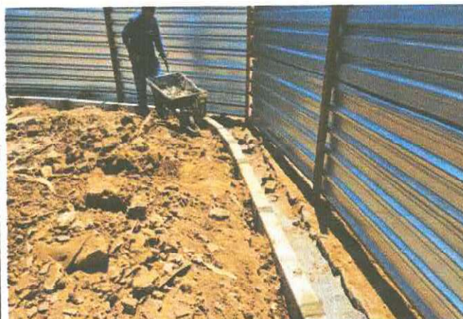
FOTO 02 - Demolição de piso em concreto
