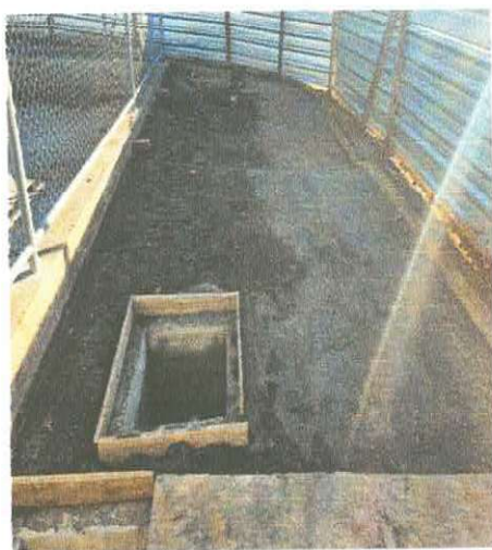
FOTO 11 - Lastro com material granular
