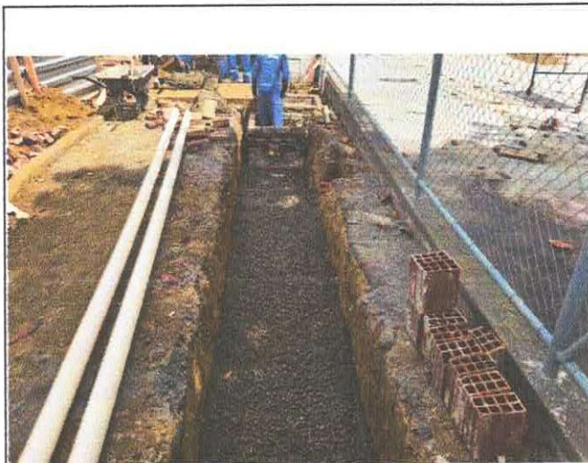
FOTO 25 - Tubos e material granular da vala de infiltração
