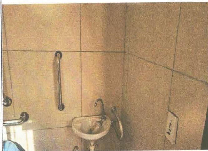
FOTO 21 - Barra de apoio reta e em U
