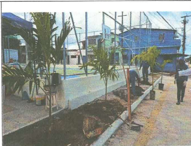
FOTO 06 - Regularização e colocação de solo para plantio de grama
