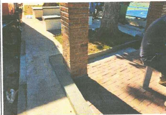
FOTO 04 - Mureta em alvenaria com pintura de piso
