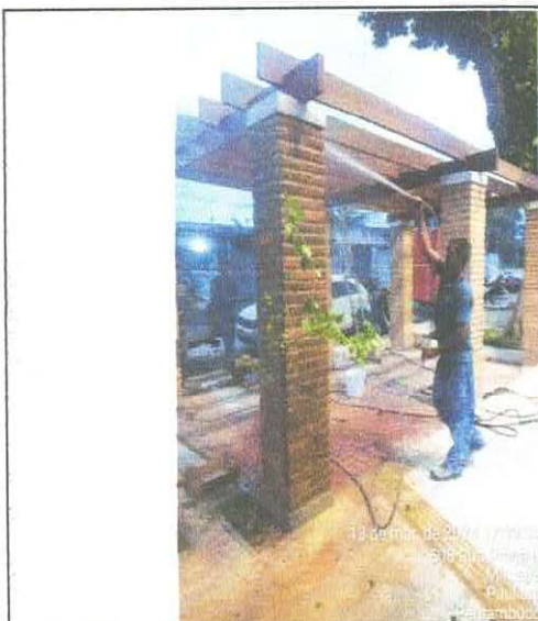
FOTO 05 - Limpeza de superfície com jato de alta pressão
