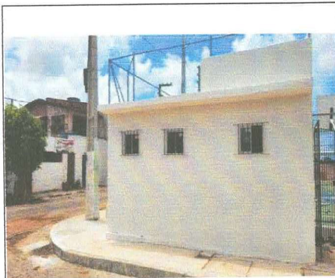
FOTO 17 - Pintura W.C/Depósito (fundo selador e textura acrílica)
