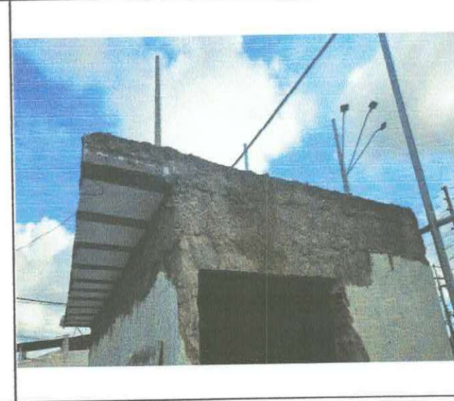
FOTO 20 - Viga em concreto armado
