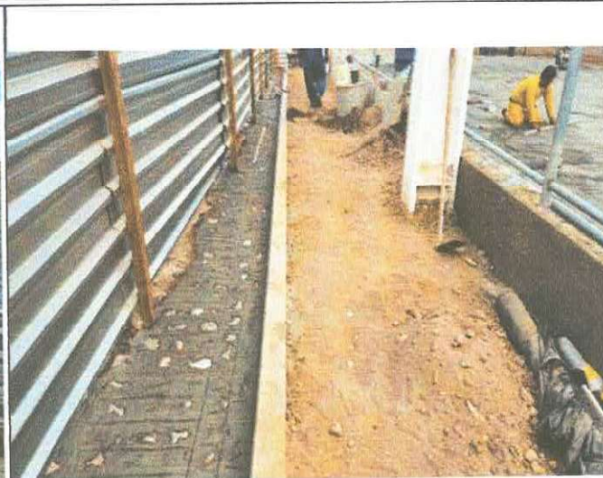
FOTO 14 - Reassentamento de paralelepípedos
