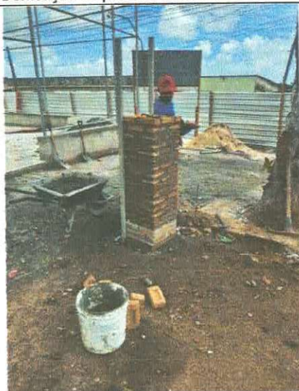
FOTO 03 - Construção de pilar em alvenaria maciça
