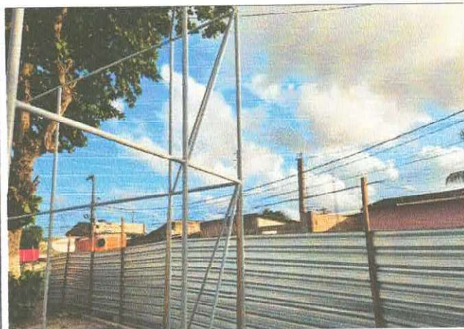
FOTO 08 - Pintura esmalte no alambrado
