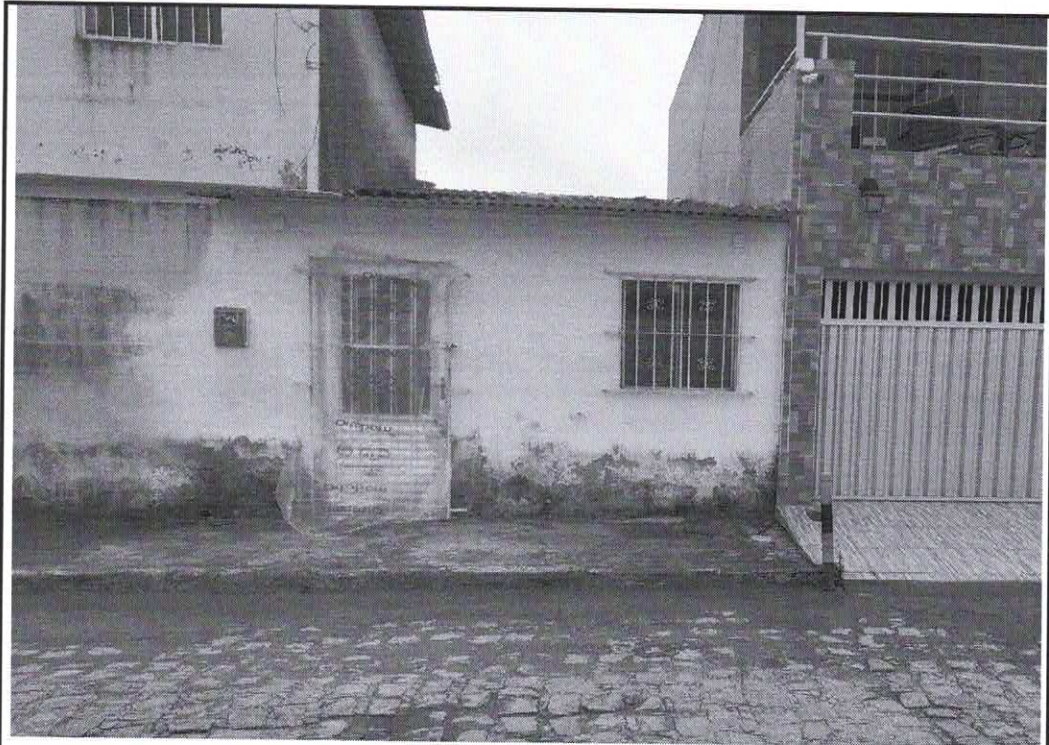
1.1.0.4 – Locação de container - Casa alugada – Excedido nos BM's 09 e 10
